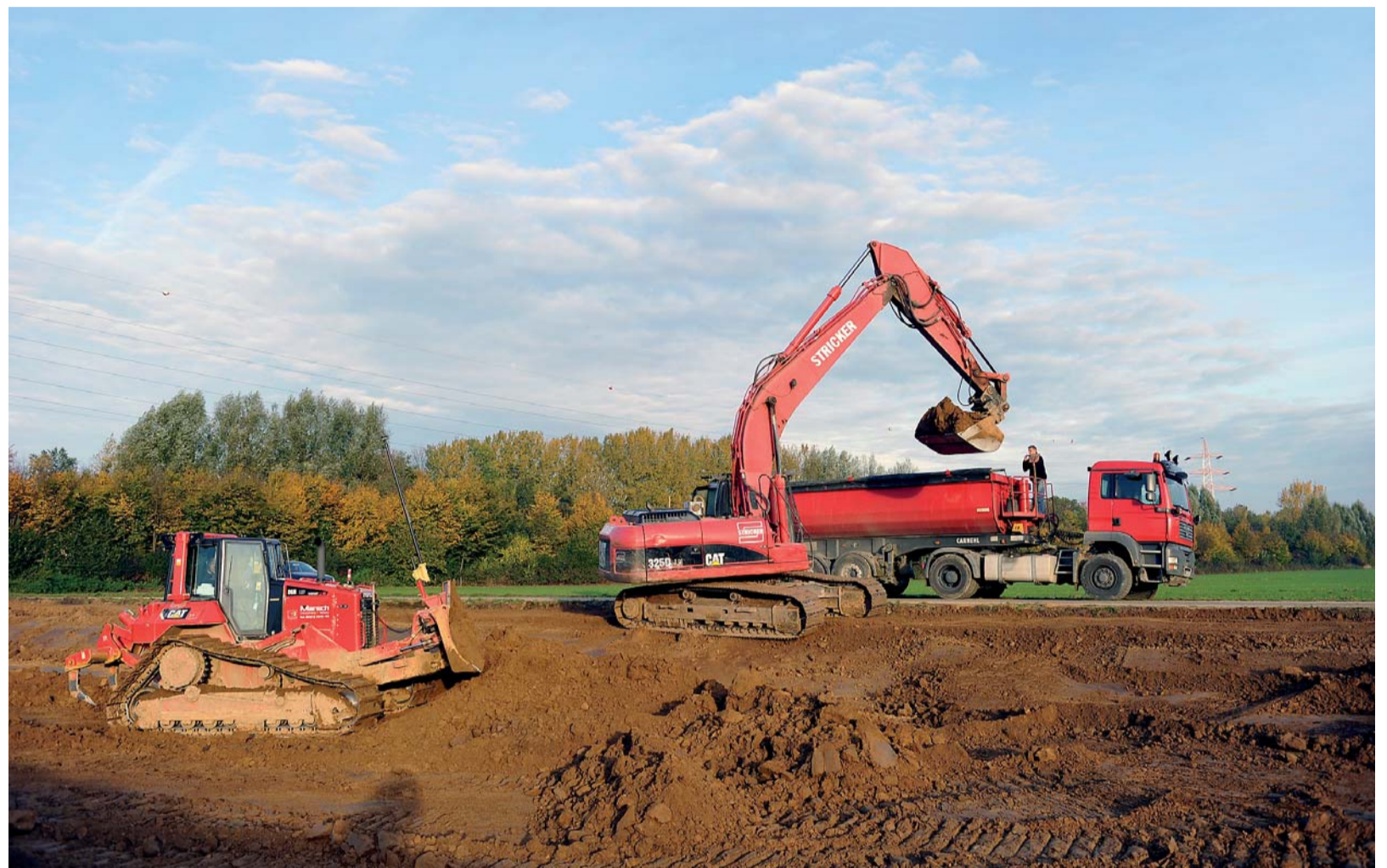
Die Gustav Marsch GmbH & Co. KG begann im Oktober 2011 mit den Erschließungsarbeiten in dem neuen Gewerbegebiet „An der Hansastrasse“ in Unna West.
