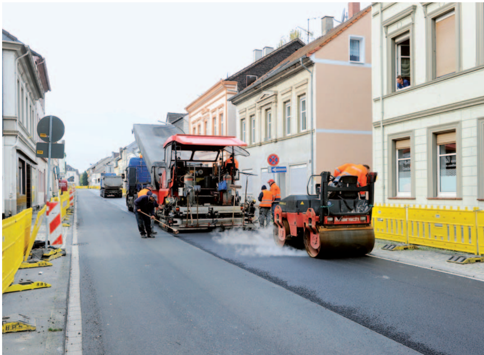
Das umfangreiche Projekt muss unter halbseitiger Weiterführung des Verkehrs in achtzehn Teilabschnitten von jeweils einer Woche Bauzeit ausgeführt werden.
