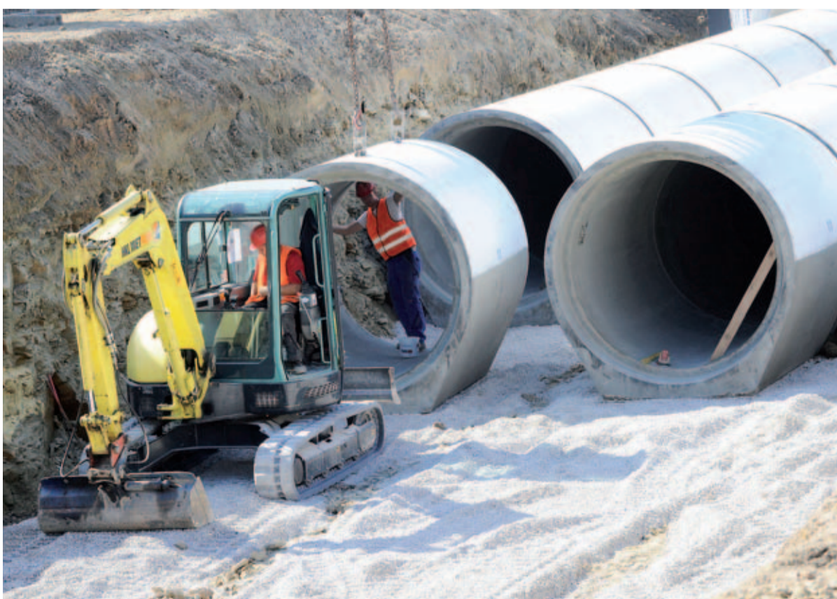
Es wurden Betonrohre mit einem Durchmesser von zwei Metern verlegt.
