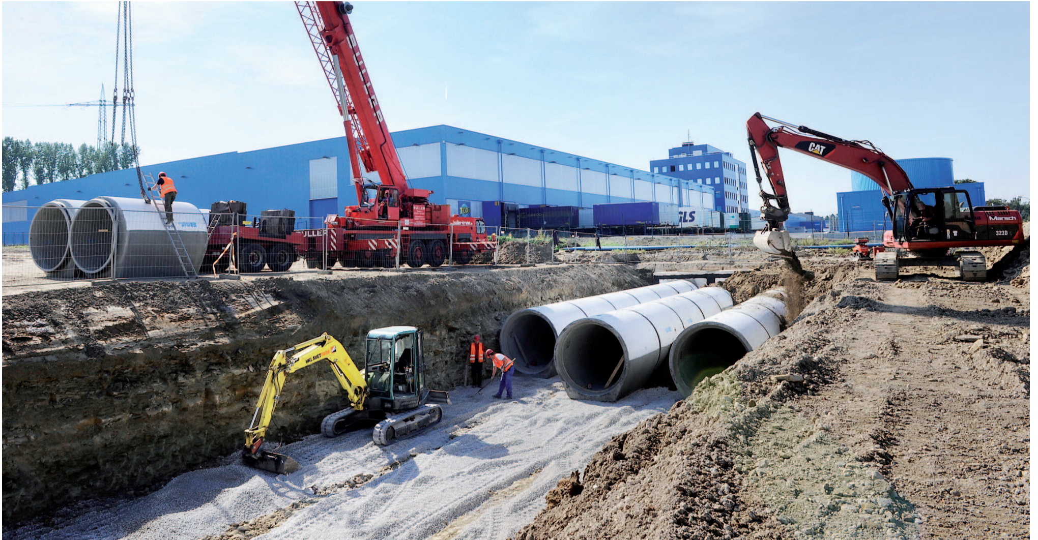
Auf dem Gelände des REWE-Zentrallagers in Dortmund übernimmt die Firma Gustav Marsch die Kanalisations- und Befestigungsarbeiten im Rahmen des Kooperationsprojektes mit der Firma Stricker.
