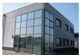
Neubau Produktions- und Lagerhalle mit Büro- und Sozialtrakt
