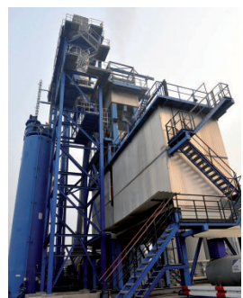
Bis zu 200.000 Tonnen Asphalt können im Emschermischwerk jährlich produziert werden.
