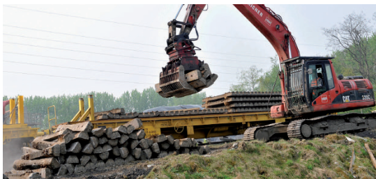
Entsorgung von Altschwellen für die DB AG.
