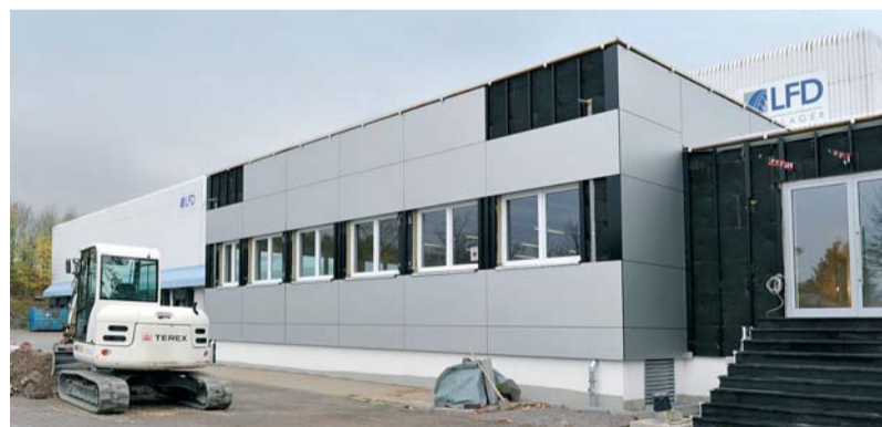
Hinterlüftete Fassade aus Schichtstoffplatten mit Metallic-Beschichtung
