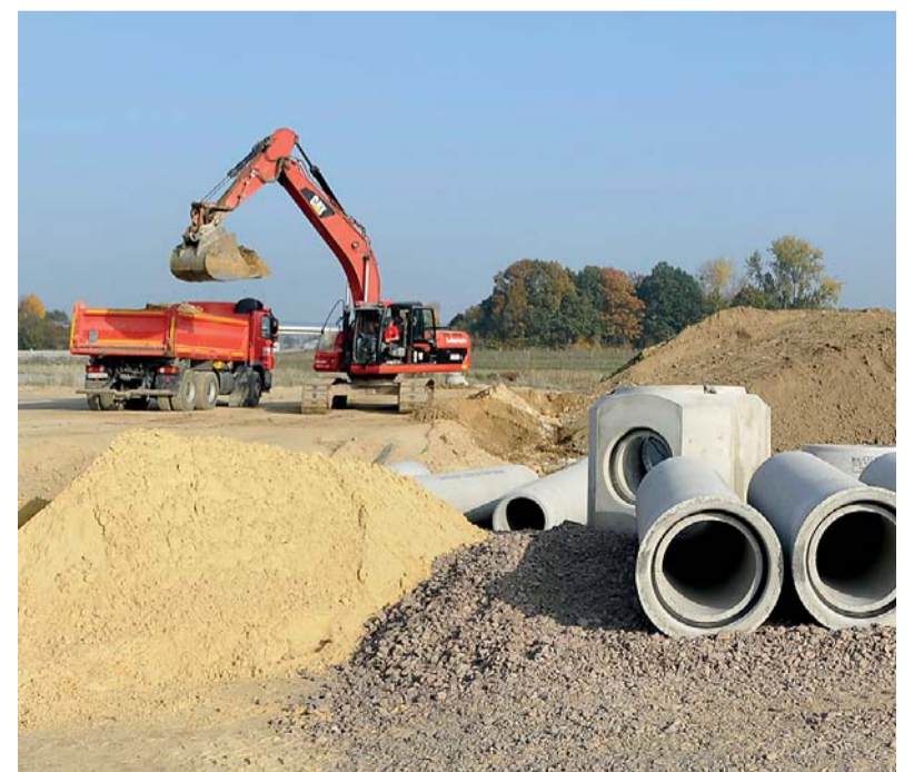
Bis Mitte kommenden Jahres sollen auf dem Gelände eine Produktionshalle mit weiteren Instandhaltungs- und Sozialflächen sowie ein Verwaltungsgebäude entstehen.
