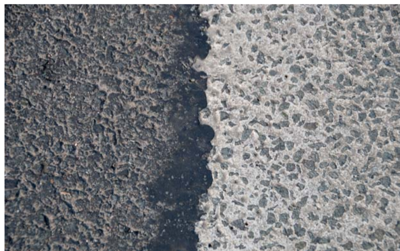
Halbstarre Deckschichten verbinden die Flexibilität und Fugenlosigkeit des Asphalts mit der hohen Tragfähigkeit und größeren Verschleißfestigkeit des Betons.
