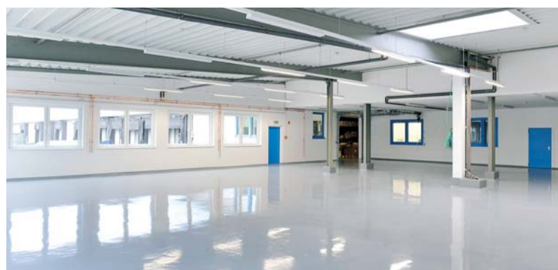
Produktionshalle mit WHG-Beschichtung
