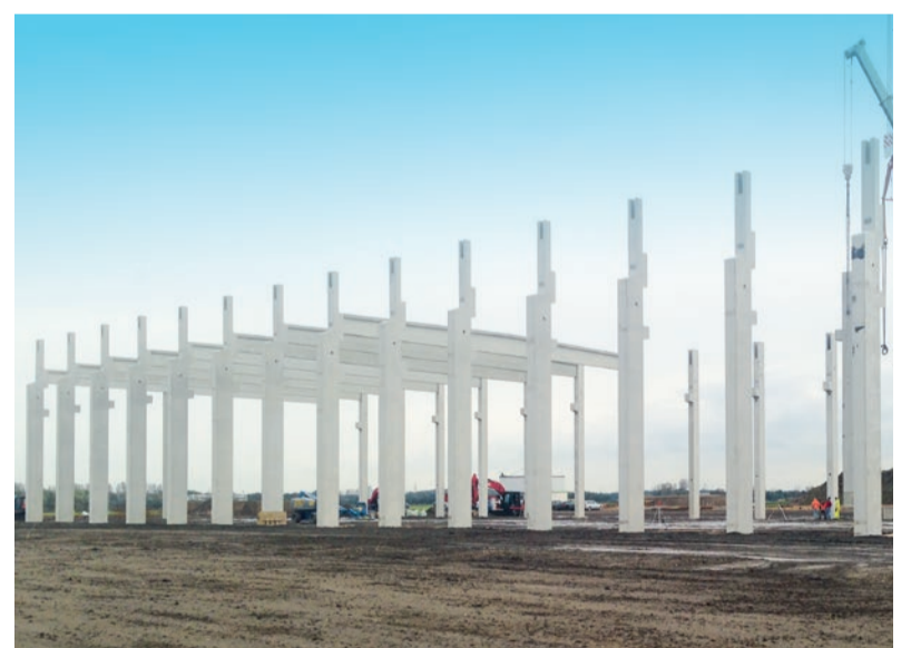
Fertigteilmontage nach Anfüllung der Fundamente
