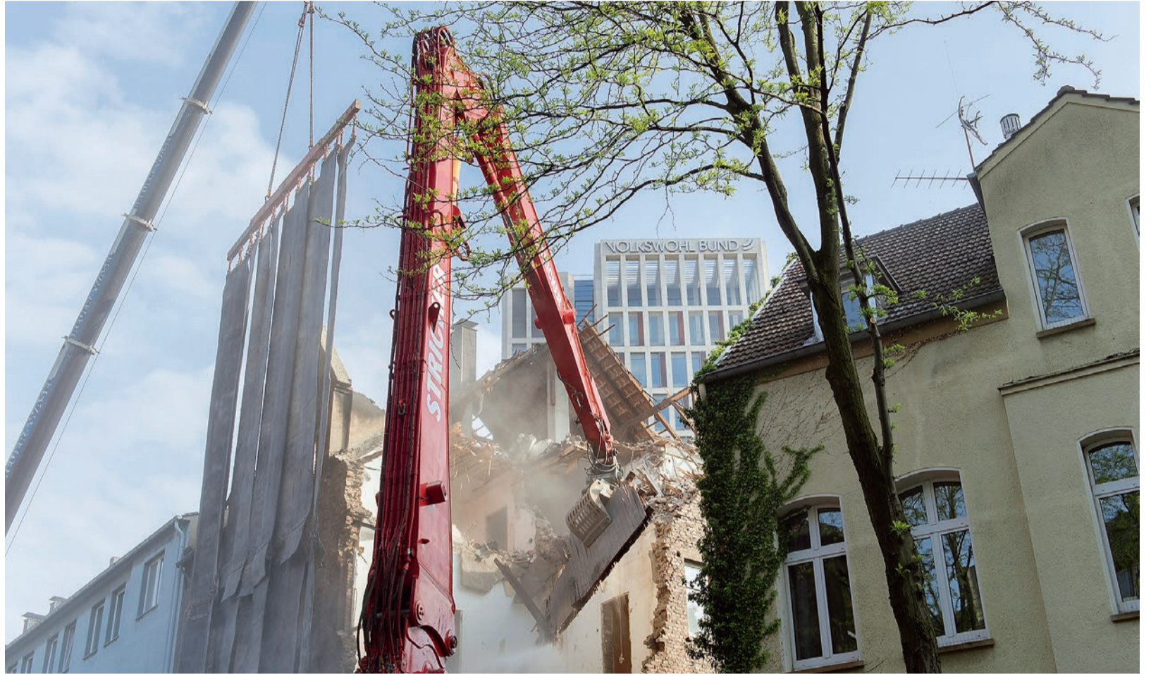
Abbrucharbeiten auf engstem Raum
