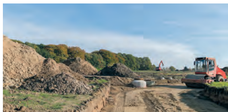
Täglich sind etwa sieben bis acht Mitarbeiter der Firma Marsch auf der Baustelle im Einsatz.
