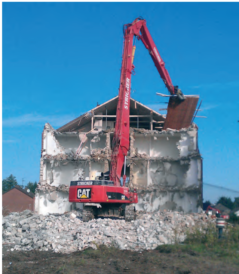
Bevor mit dem Rückbau der Gebäude begonnen werden konnte, erfolgten vorbereitende Maßnahmen zum Artenschutz.
